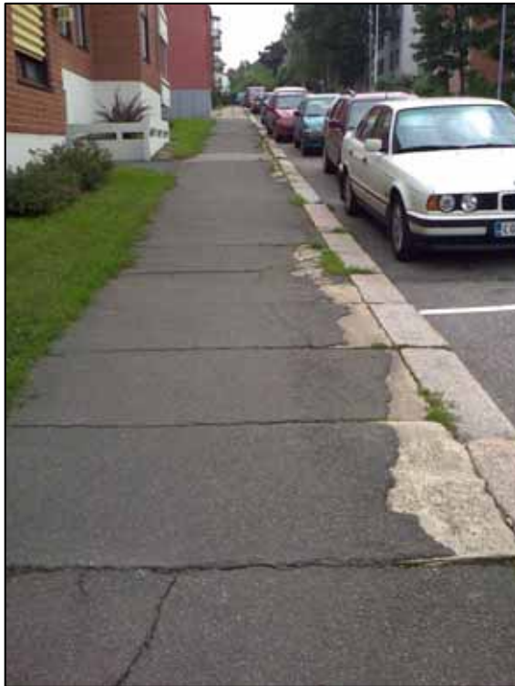
Kuva 61. Raastuvankadun epätasainen jalkakäytävä tulee pinnoittaa uudelleen pienillä betonilaatoilla tai betonikivillä
