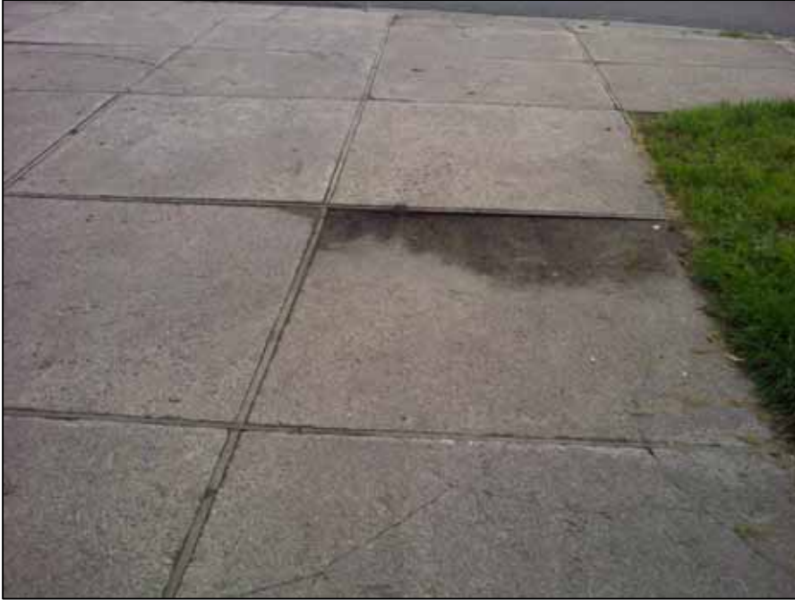
Kuva 69. Koulukadun ja Raatimiehenkadun kulmauksessa oleva yksittäinen kuoppa tulee korjata
