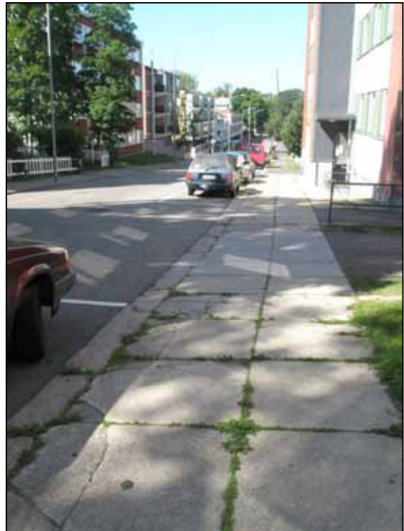
Kuva 61. Raastuvankadun epätasainen jalkakäytävä tulee pinnoittaa uudelleen pienillä betonilaatoilla tai betonikivillä
