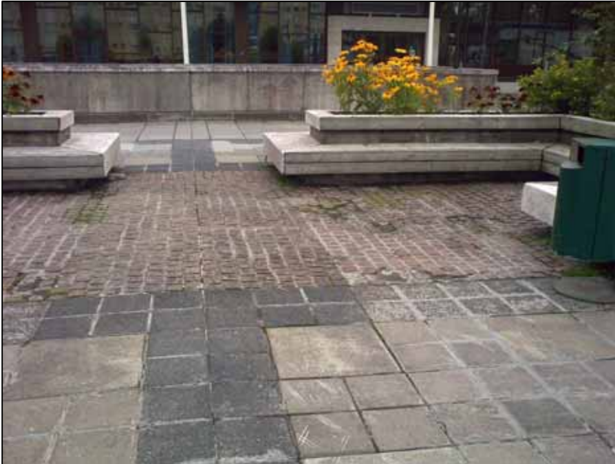
Kuva 27. Kaupungintalon aukiolla on käytetty pintamateriaalina useita erikokoisia betonilaattoja ja kiveyksiä
