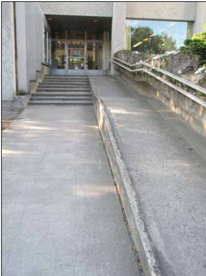
Kuva 77. Kirjaston portaat ja luiska tulee rakentaa uudelleen esteettömyysohjeiden mukaisesti
