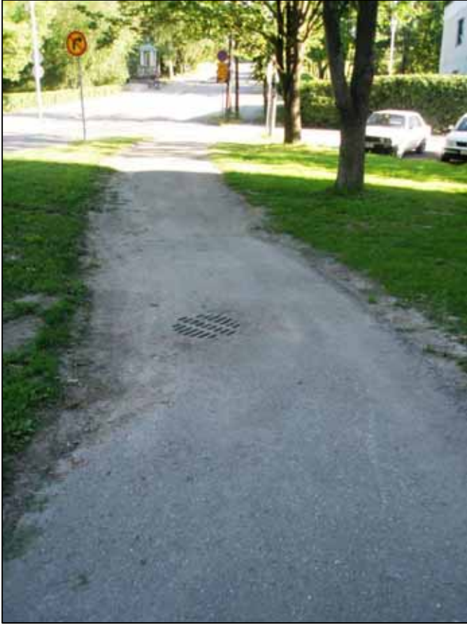
Kuva 72. Kristiinankadun epätasainen jalkakäytävä tulee asfaltoida uudelleen
