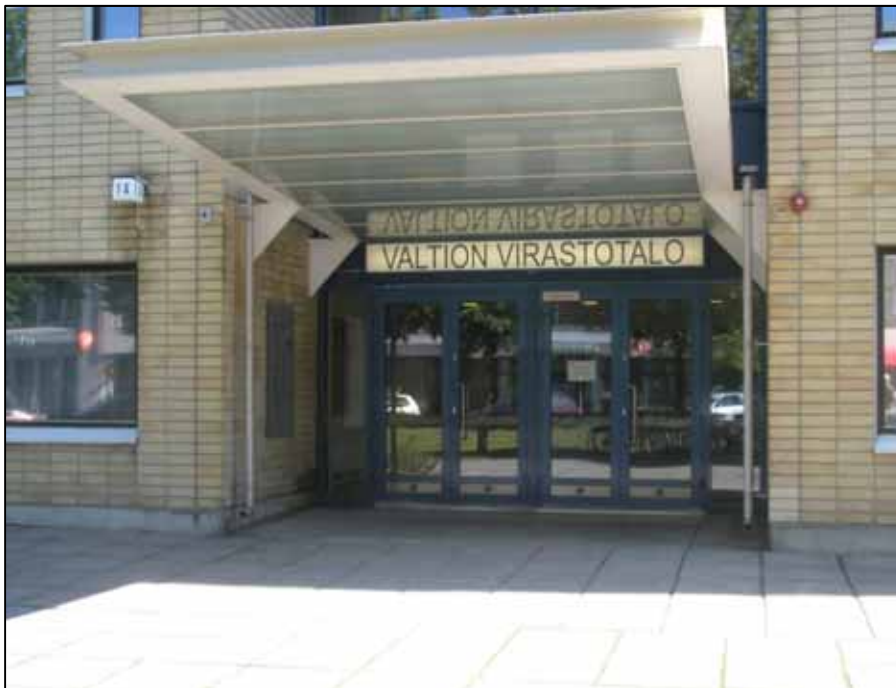
Kuva 78. Valtion virastotalon Pormestarinkadun puoleiseen sisäänkäyntiin tulee rakentaa maksimissaan 8 prosenttia kalteva luiska
