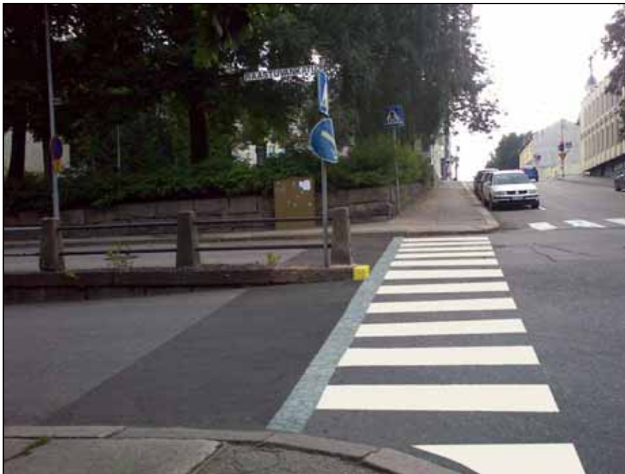
Kuva 68. Havainnekuva Kirkkokadun ja Raastuvankadun risteyksen suojatiestä. Keskikaiteen alareunaan on lisätty huomiovärinen maalaus, suojatiemerkinä on kavennettu käytettävissä olevan kulkutilan levyiseksi ja suojatiemerkinän kaiteen puoleiseen reunaan on lisätty nupukiviraita
