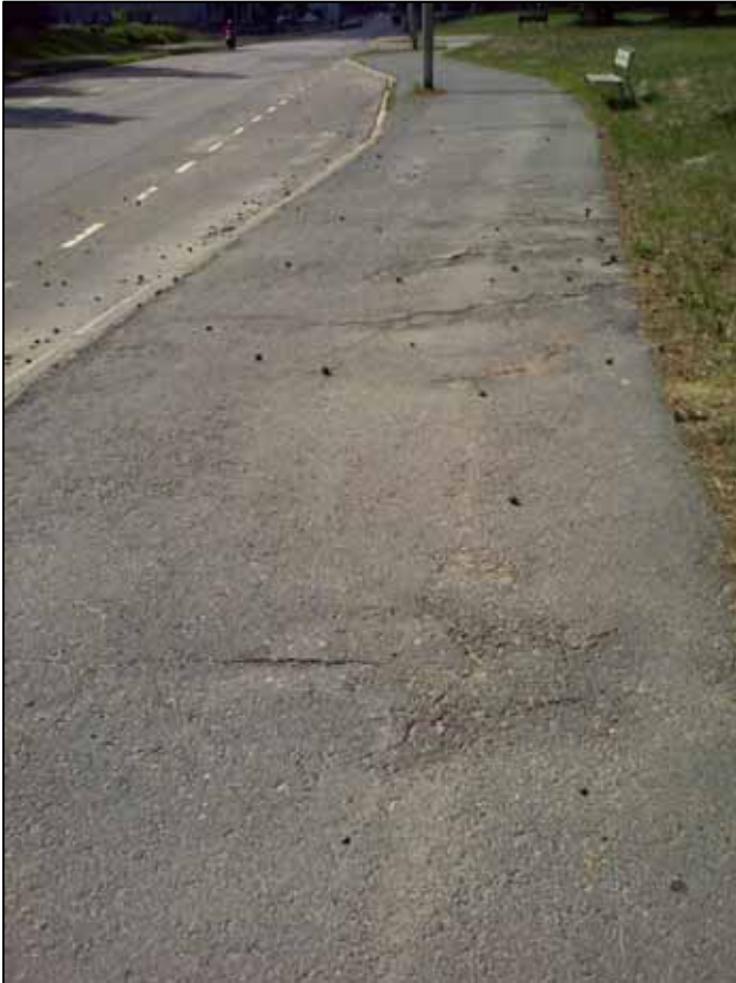
Kuva 54. Armilankadun bussipysäkin kohdalla asfalttipäällyste on erittäin epätasainen
