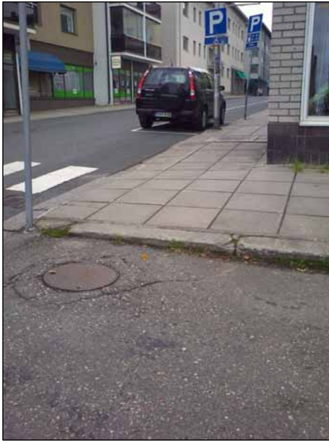
Kuva 10. Raatimiehenkadun ja Koulukadun risteyksessä kevyen liikenteen väylä katkeaa ennen suojatietä
