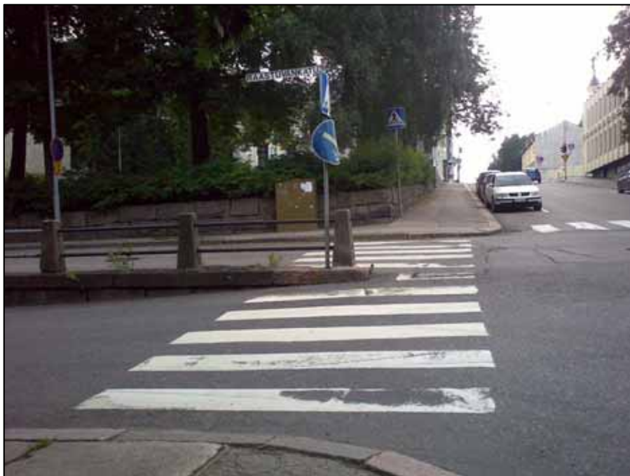
Kuva 14. Raastuvankadulla keskikaide keskellä suojatietä muodostaa törmäämisvaaran heikkonäköiselle tai sokealle henkilölle
