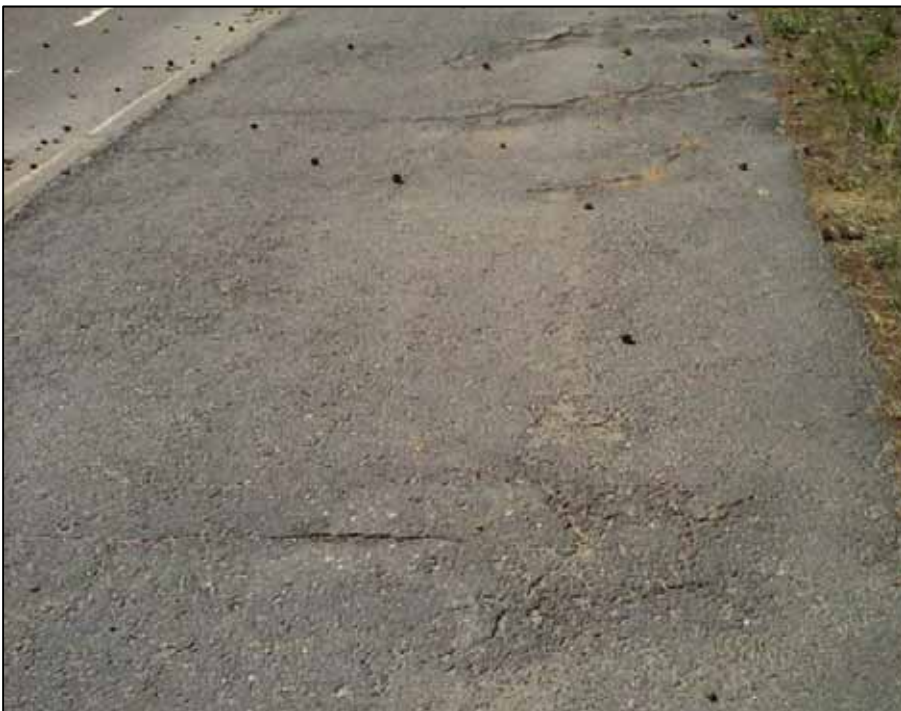
Kuva 85. Epätasainen jalkakäytävä bussipysäkin edustalla tulee asfaltoida uudelleen
