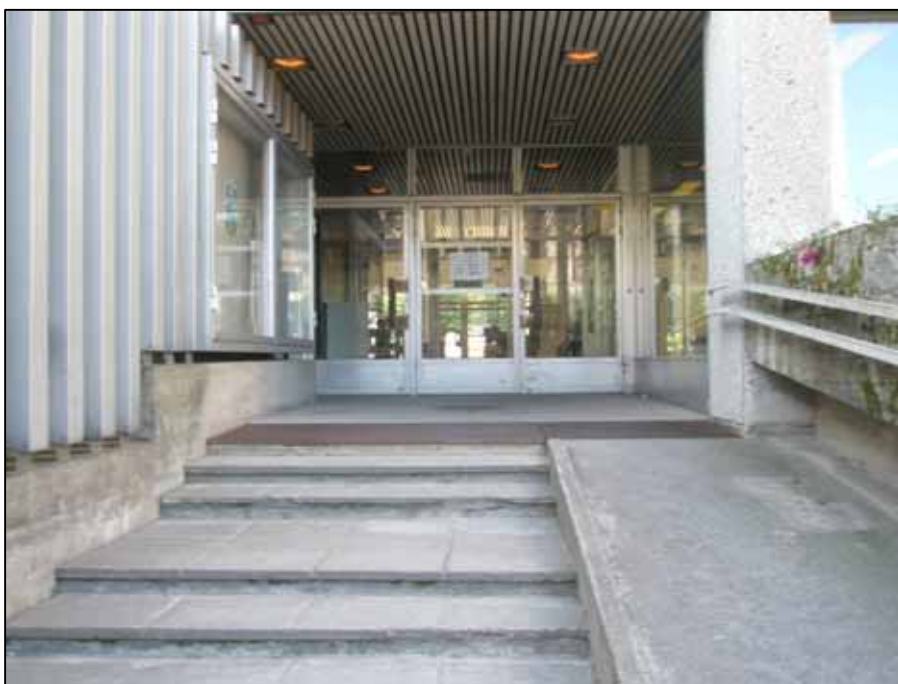
Kuva 38. Kirjaston Valtakadun puoleisessa sisäänkäynnissä on huonokuntoiset portaat ja luiska
