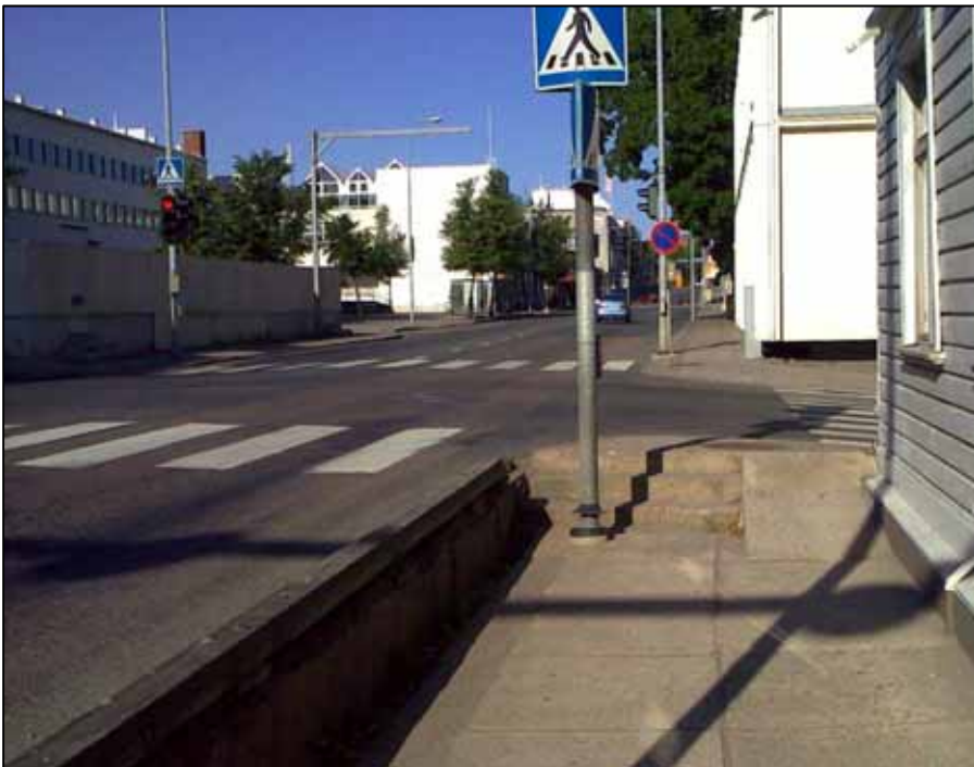
Kuva 66. Koulukadulla Kirkkokadun risteyksessä oleva kohta vaatii useita toimenpiteitä
