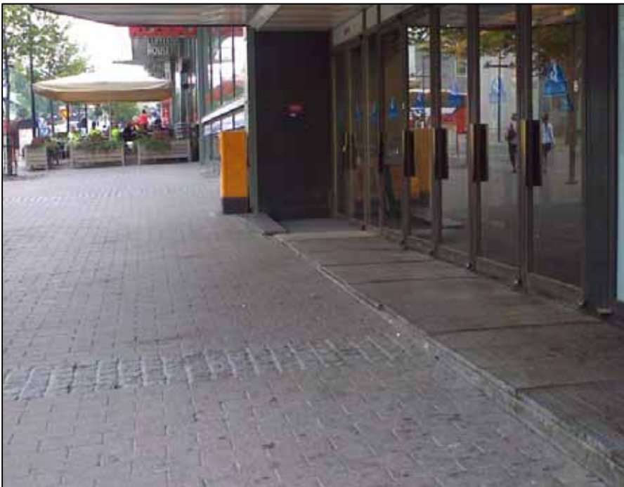
Kuva 45. Kauppakeskus Armadan pohjoisemmassa sisäänkäynnistä on vaikea kulkea yksin apuvälineiden kanssa kynnyksien ja raskaiden ovien vuoksi
