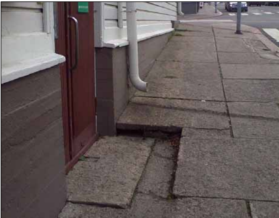
Kuva 48. Syvennys kiinteistön oven kohdalla aiheuttaa putoamisvaaran kevyen liikenteen väylällä kulkeville
