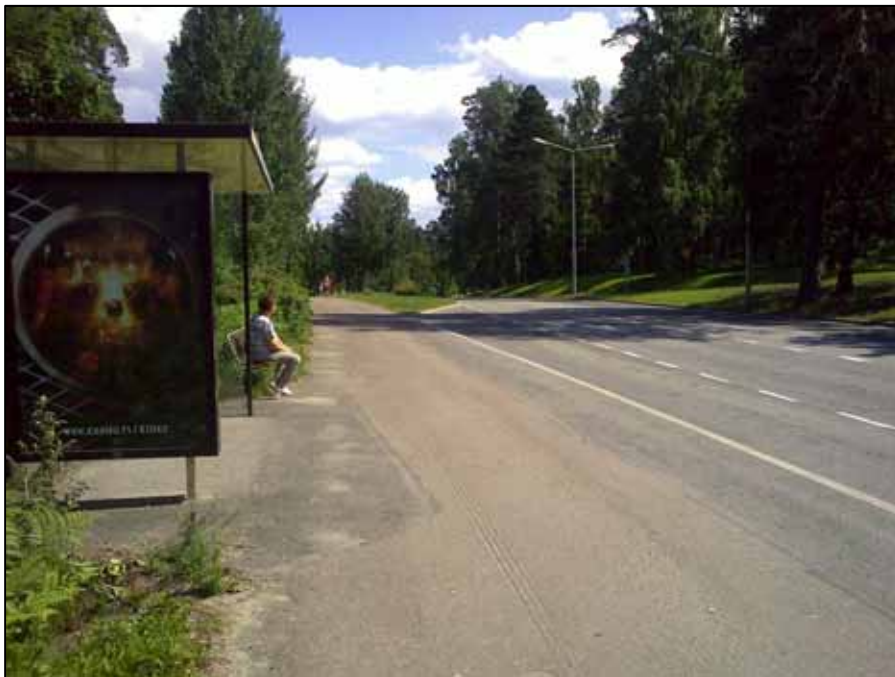
Kuva 52. Pyörätie kulkee bussipysäkin edestä, mikä aiheuttaa vaaratilanteita pysäkillä odottavien tai bussin kyytiin nousevien ja ohi ajavien pyöräilijöiden kesken
