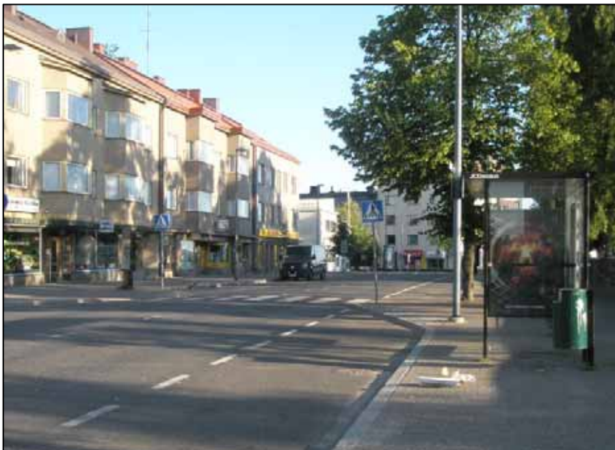
Kuva 62. Kauppakadun bussipysäkin pysäkkialue tulee korottaa niin, että reunatuen näkyvä osuus on 12 cm
