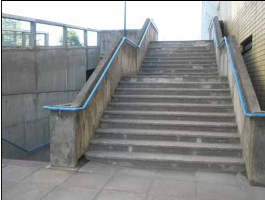
Kuva 73. Raatimiehenkadulta ja Kirkkokadulta ylemmälle jalankulkutasolle nousevat portaat tulee rakentaa uudelleen esteettömyyssohjeiden mukaisesti
