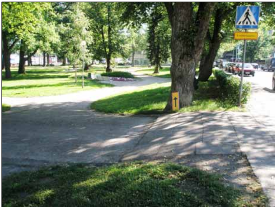
Kuva 58. Laivatien eteläpään luiskaukset tulee rakentaa maksimissaan 8 prosentin kaltevuuteen
