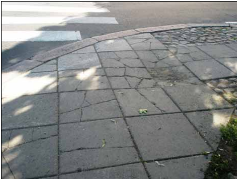
Kuva 5. Ydinkeskustan jalkakäytävien betonilaatoitus on monin paikoin halkeillut ja epätasainen
