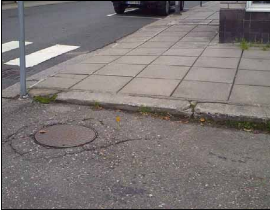
Kuva 70. Koulukadun ja Raatimiehenkadun kulmauksessa oleva jalkakäytävä tulee asfaltoida uudelleen ja tasoero poistaa jalkakäytävältä
