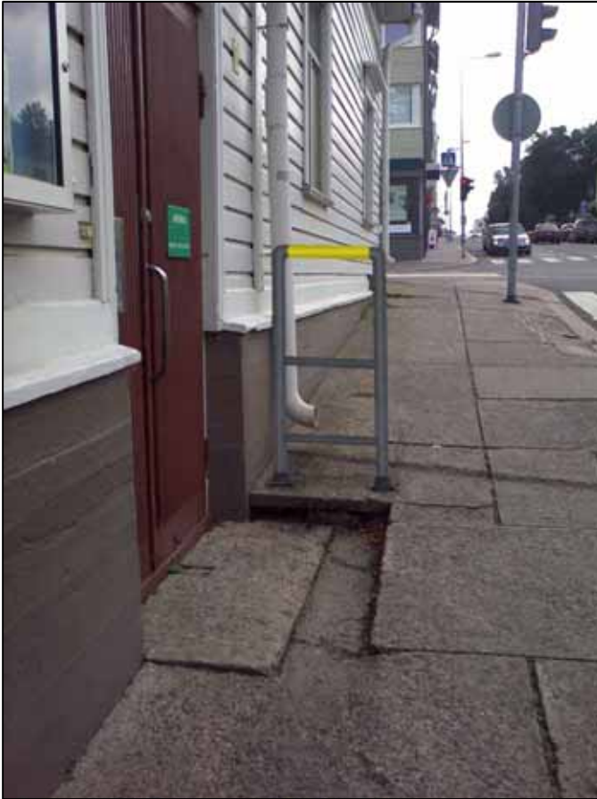
Kuva 65. Havainnekuva jalkakäytävän pudotuksen kohdan kevytkaitteesta
