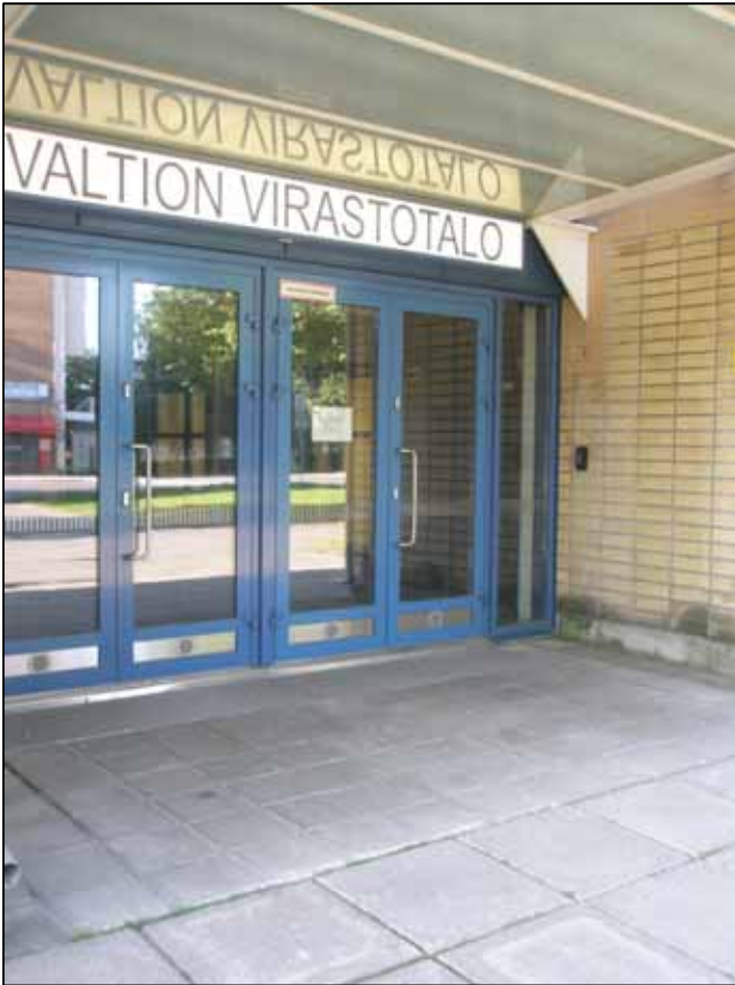
Kuva 41. Valtion virastotalon Pormestarinkadun puoleisessa sisäänkäynnissä on korkea kynnyks
