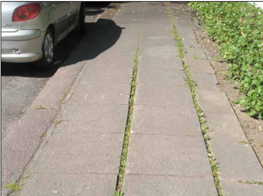
Kuva 60. Aionkadun epätasainen jalkakäytäväosuus tulee pinnoittaa uudelleen pienillä betonilaatoilla tai betonikivillä
