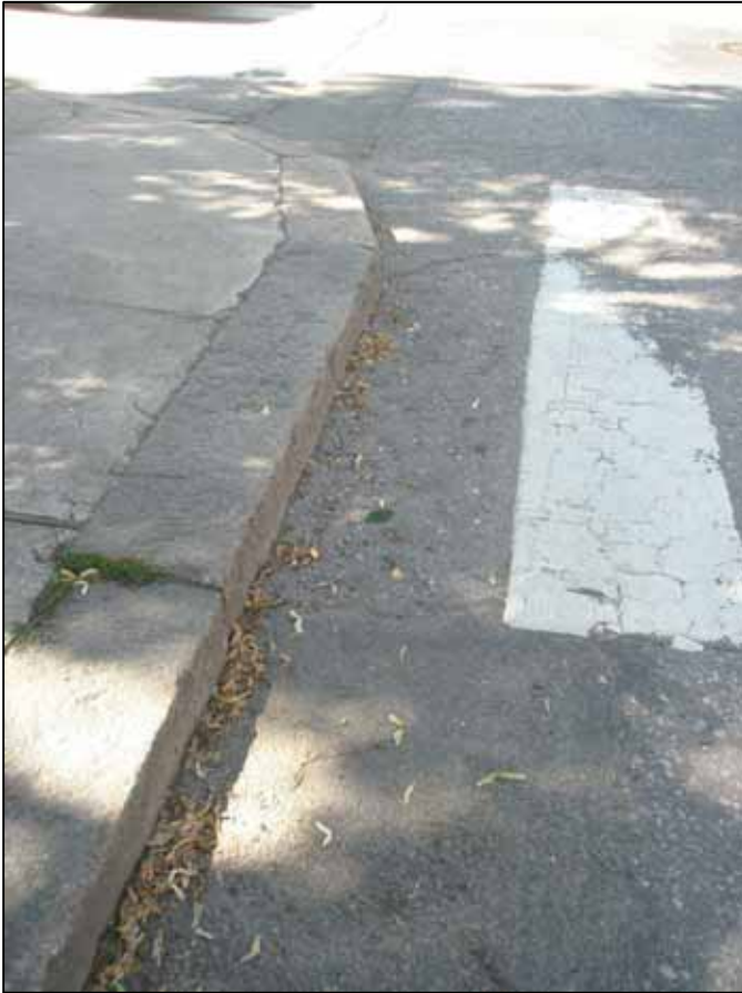
Kuva 11. Korkea reunatuki aiheuttaa esteen apuvälineiden kanssa liikkuvalla henkilölle
