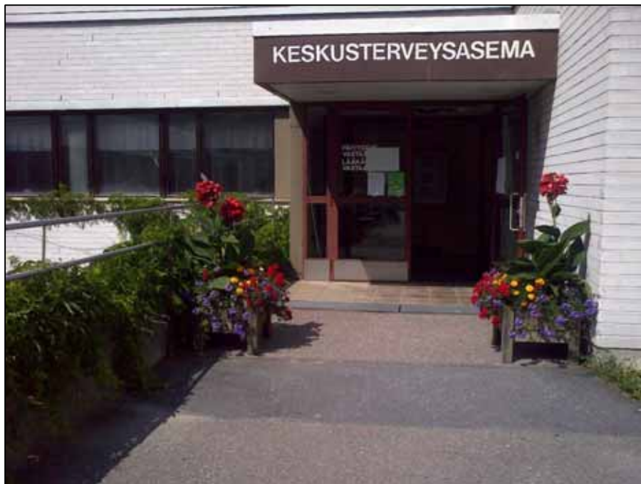
Kuva 57. Armilan sairaalan terveysasemanpuoleinen sisäänkäynti
