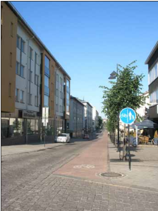
Kuva 3. Valtakadun uusituilla väyläosuksilla jalankulku ja pyöräily on eroteltu toisistaan
