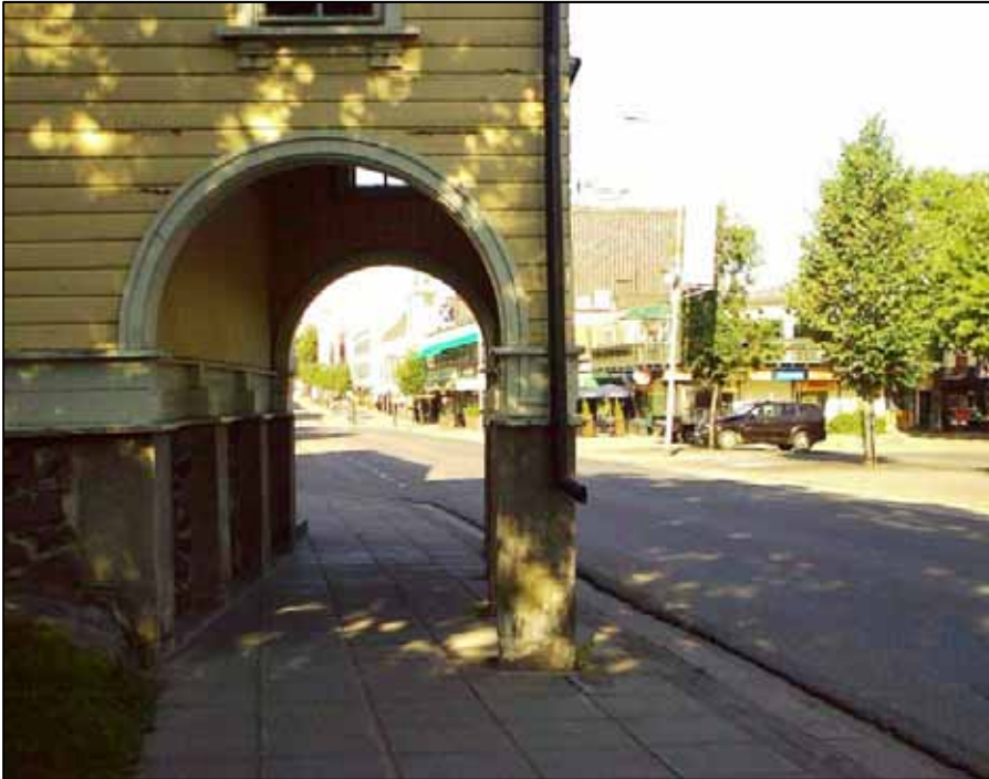
Kuva 47. Lappeen Marian kirkon pilari keskellä kevyen liikenteen väylää aiheuttaa törmäämisvaaran heikkonäköiselle tai sokealle henkilölle
