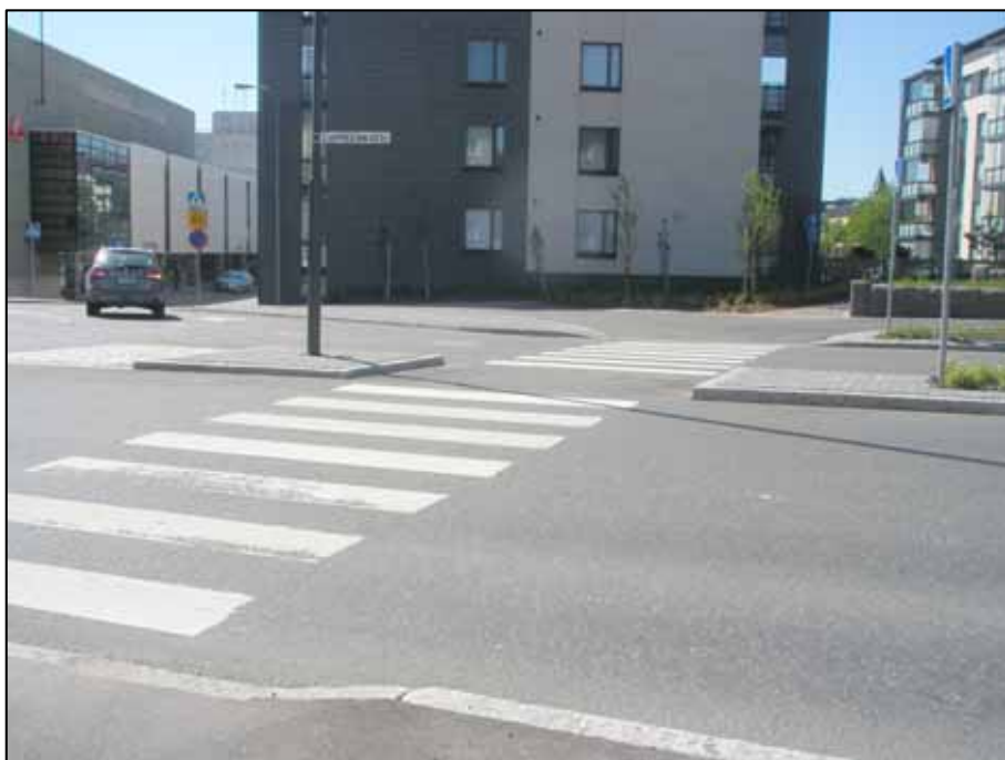
Kuva 17. Lappeenkadun uusitut suojaiesarekkeet ovat syvyydeltään vähintään 2,5 metriä
