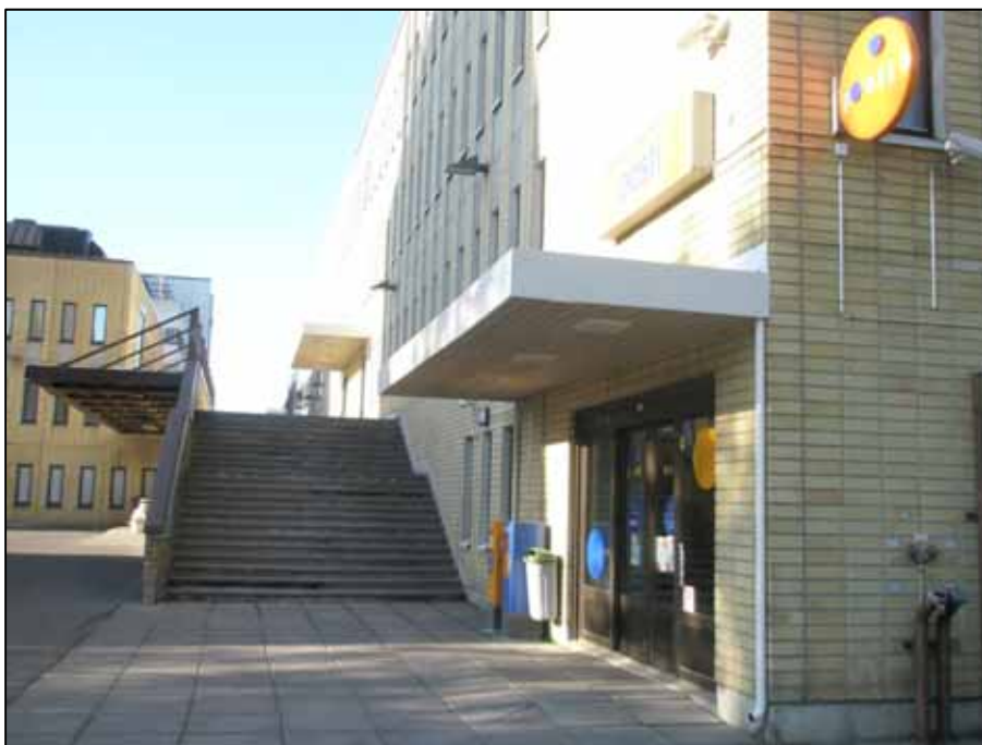
Kuva 79. Postin vierestä ylemmälle jalankulkutasolle nousevat portaat tulee rakentaa uudelleen esteettömyyssohjeiden mukaisesti
