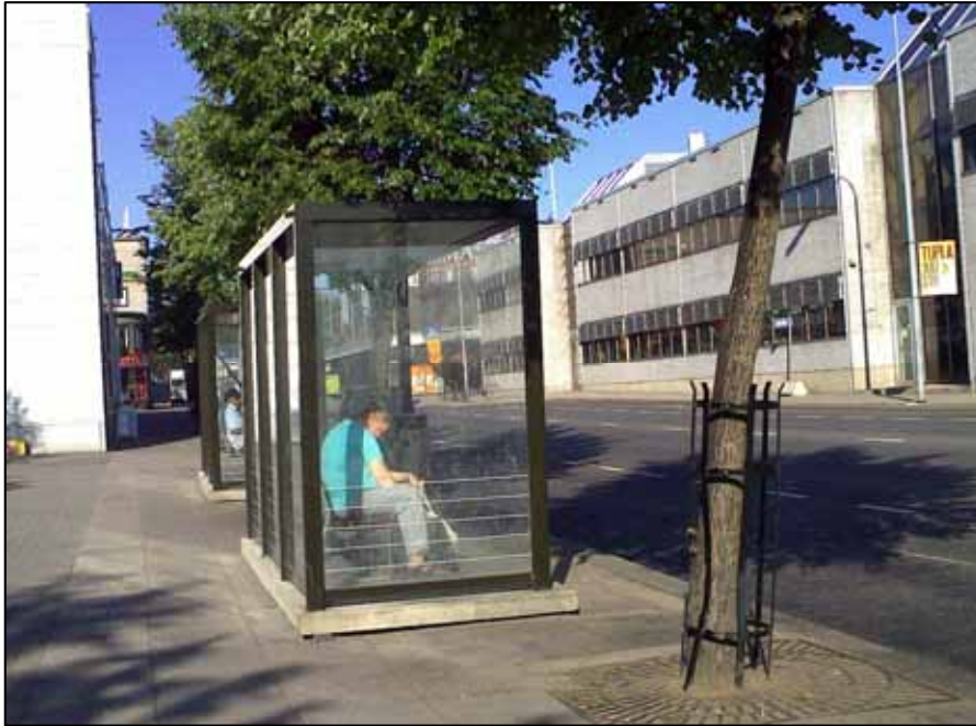
Kuva 19. Koulukadun pysäkkikatokset ovat betonikorokkeella
