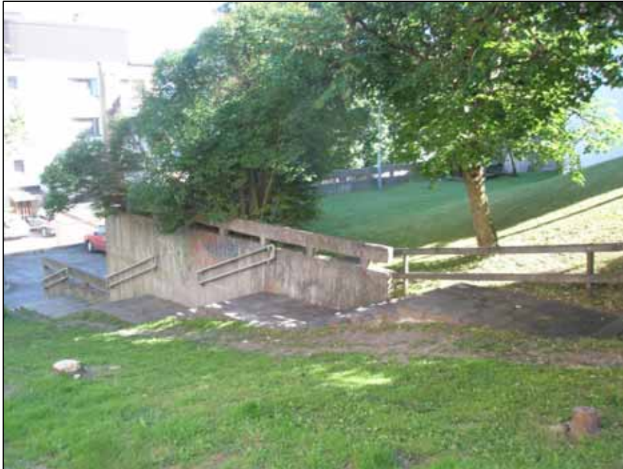
Kuva 64. Raatimiehenkadun portaisiin tulee lisätä istutusten puolelle käsijohteet kahdelle korkeudelle 90 cm ja 70 cm
