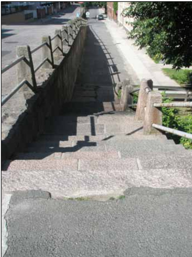
Kuva 31. Raastuvankadun portaiden kiviset askelmat ovat hyväkuntoiset, mutta portaiden yläpäässä on epätasaista asfalttia
